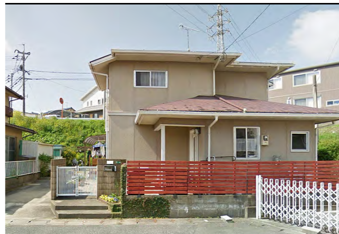
建物全体の外観。軽量鉄骨造りスレート葺2階建てです。
